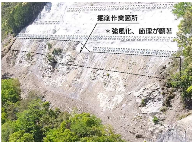
(図-3) 掘削作業箇所
