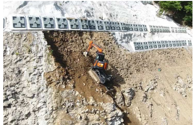
(図-7) MGシステムによる法面掘削
