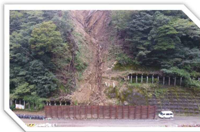
掘削前 R3.8月
